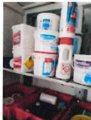
3- Cuvette de rétention local 1 de 5 Produits dangereux non triés et déchets dangereux non propre incompatibles
