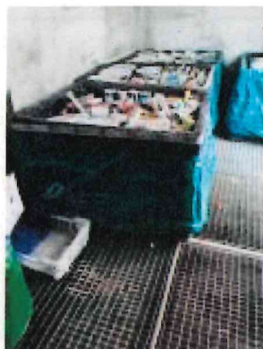
3- Cuvette de rétention local 1 de 5 Produits dangereux non triés et déchets dangereux non propre incompatibles
