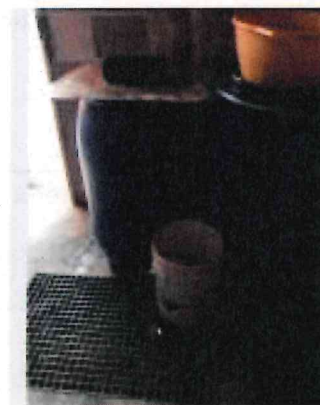
4- Cuvette de rétention local 2 de 6- bidons huile hors rétention déchets dangereux non propre
