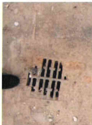
8 et 9 Regards eaux pluviales obstrués
